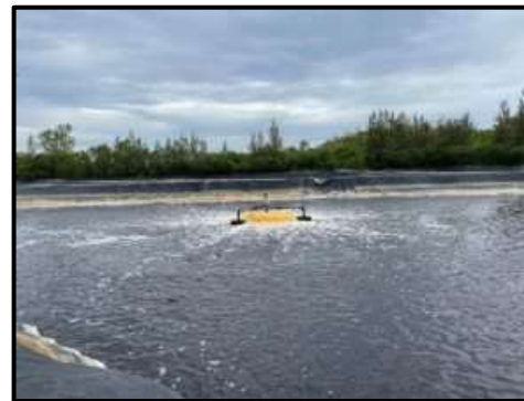
จัดให้มีระบบบำบัดน้ำเสียแบบบ่อบำบัดทางชีวภาพ
