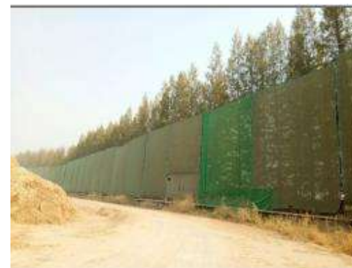
ติดตั้งตาข่ายป้องกันฝุ่นรอบกองเชื้อเพลิง ฉีดพรมน้ำลานกองเชื้อเพลิงเพื่อลดการฟุ้งกระจายของฝุ่นละออง
